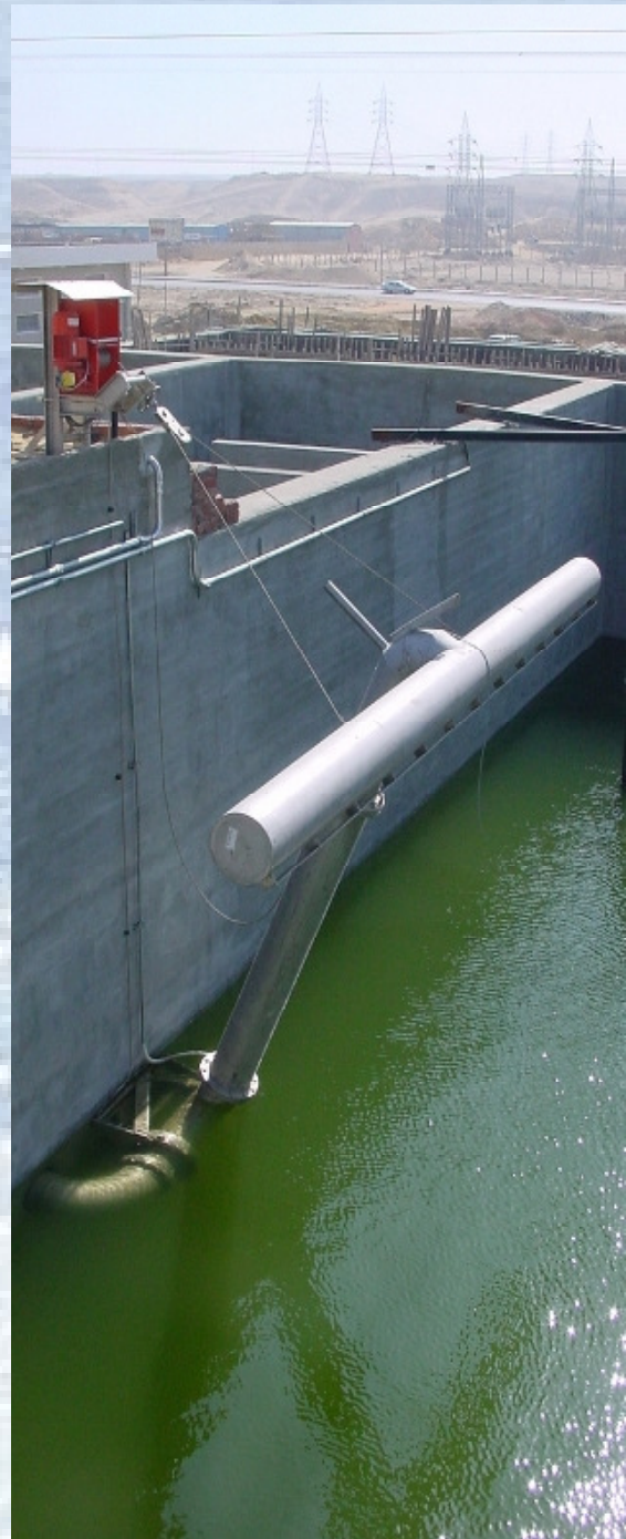
埃及Amreya污水处理厂的DN300清水滗水器。
