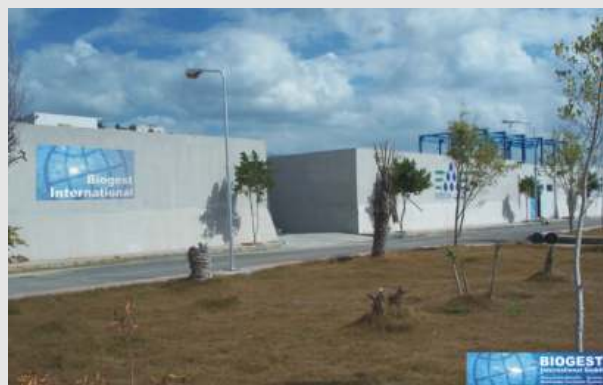
Biogest-Kläranlage der ägyptischen Stadt "Amreya" bei Alexandria. Die hydraulische Leistung liegt zwischen 5.000 – 6.000 m 3 /d, welche mit 3 SB-Reaktoren behandelt wird. Belüften und Rühren erfolgt durch schwimmende BSK ® -Turbinen Ø 2.50 m.
