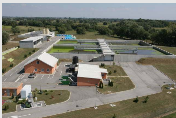
Vogelperspektive auf die Kläranlage der Stadt Koprivnica (100.000 EW), welche von der Biogest International GmbH entworfen und realisiert wurde und welche nach der SBR-Betriebsweise (4 Reaktoren) arbeitet.
