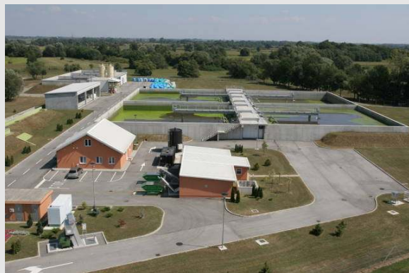
Vogelperspektive auf die Kläranlage der Stadt Koprivnica (100.000 EW), welche von der Biogest International GmbH entworfen und realisiert wurde und welche nach der SBR-Betriebsweise (4 Reaktoren) arbeitet.
