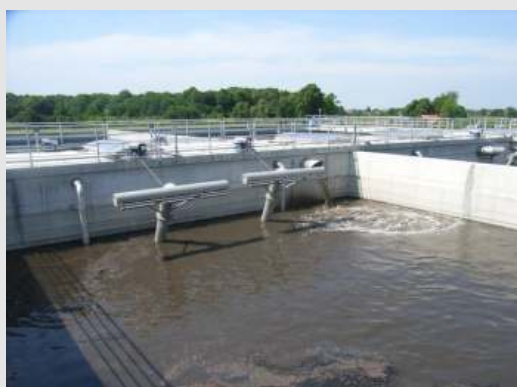
Der wartungsfreie BSK®-Dekanter ist in vielen SB-Reaktoren mit großem Erfolg im Einsatz.
