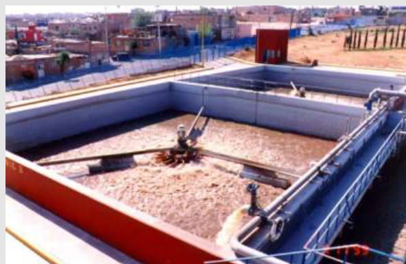
Seit 1995 arbeitet die Kläranlage für die eine mexikanische Stadt (Aguascalientes) basierend auf der Technologie der Biogest International GmbH (schwimmende Belüfter in insgesamt 5 SB-Reaktoren). Der Anschlusswert liegt bei 40.000 EW.
