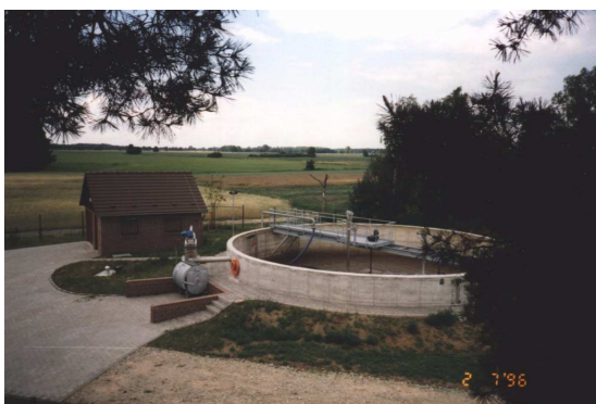
Biogest-Kläranlage der Gemeinde Wellmitz (1.500 EW)
