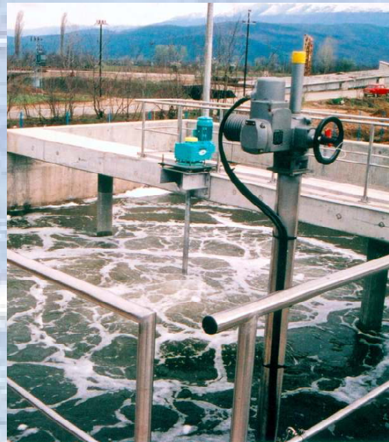
Abbildung Nr. 6: Ein HYPERCLASSIC®-Begasungssystem in einer SBR-Kläranlage, die für die SEE-Universität der Stadt Tetovo (Mazedonien) von der Biogest International GmbH schlüsselfertig erstellt wurde.
