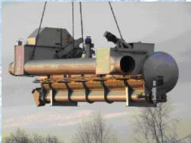
Kompakte Vorklärstation mit Walzensandfang kurz vor dem Einbau in das vorbereitete Gebäude.
