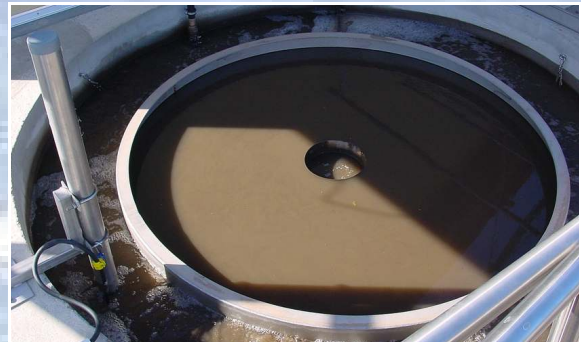
Belüfteter Rundsandfang
