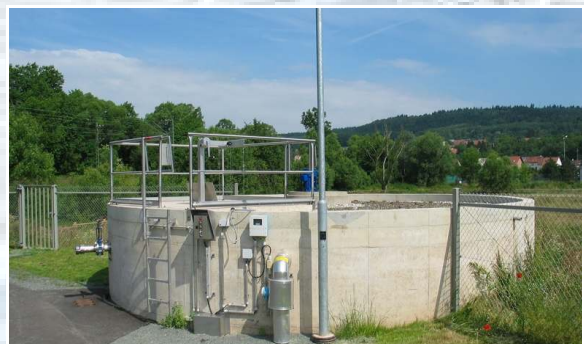
Abgedecktes Schlamm-silo
