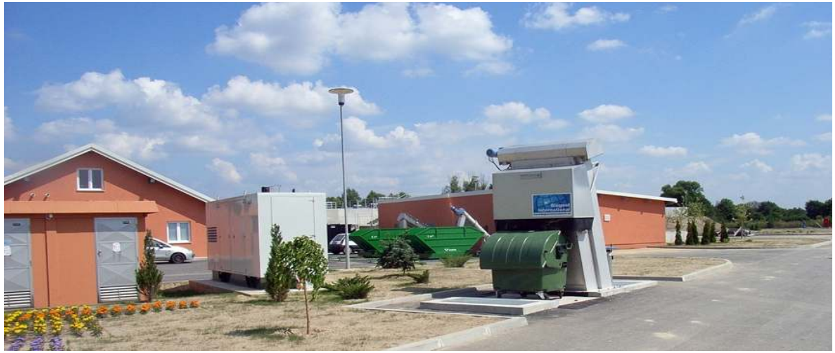
Ein automatischer Grobrechen sorgt für die Abscheidung von groben Stoffen wie Ästen, Dosen, Tierkadaver etc.
