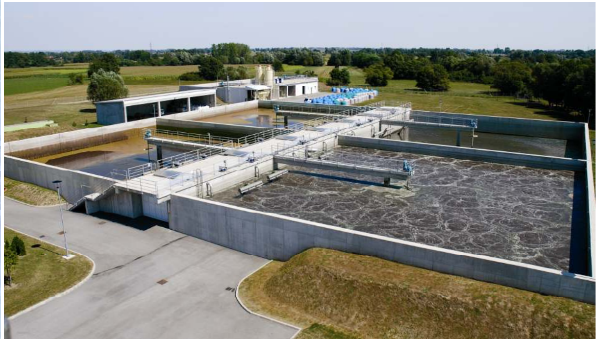
Biologischer Teil der Kläranlage KOPRIVNICA aus der Vogelperspektive
