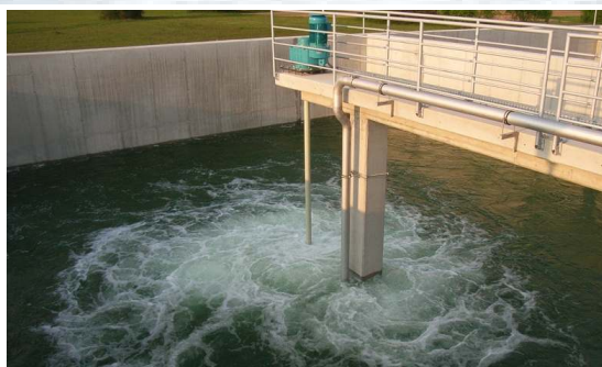
HyperClassic-Rühr- und Begasungssysteme erzielen eine Nachstabilisierung des gespeicherten Überschussschlamm.
