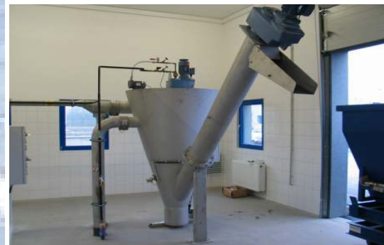
Sandwäscher mit Sandaustragschnecke
