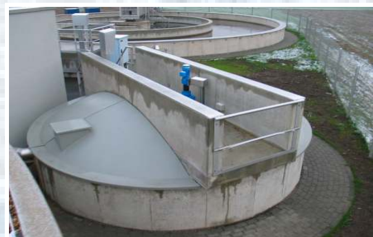
Schlammverdicker (abgedeckt)
