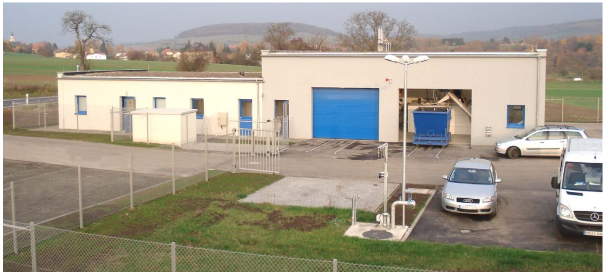
Betriebsgebäude der Kläranlage Gersheim mit Maschinenhalle (sichtbar: Sandcontainer) und Zentralspumpwerk im Vordergrund
