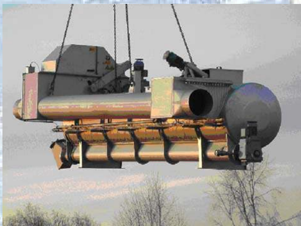
Kompaktna predtretmanska stanica neposredno prije ugradnje u pripremljeni objekt.
