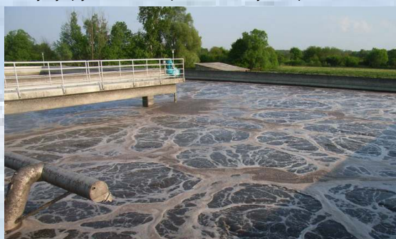
Pogled na jedan od četiri SB-reaktora sa centralno postavljenim HyperClassic-uređajem za miješanje te BSK®-dekanterom za odvod bistre vode.
