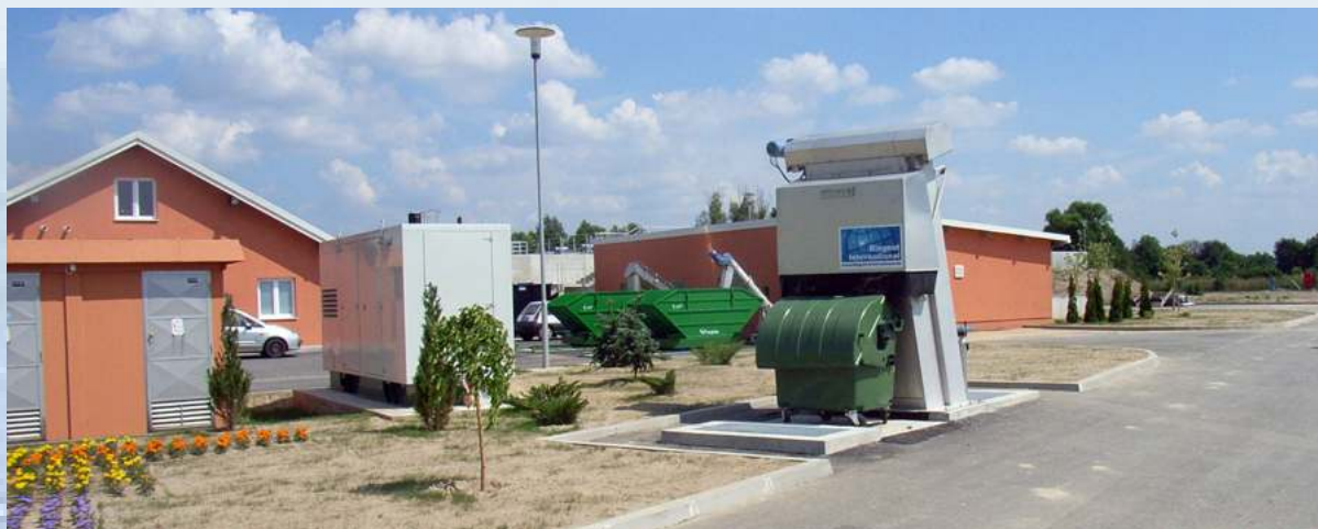
Automatska gruba rešetka uklanja čvrsti otpad poput grana, konzervi, strvina itd.
