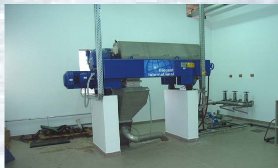
Mulj se dehidrira pomoću visokoučinske centrifuge (20 – 30 % ST-a), za jednostavno zbrinjavanje, odn. daljnju uporabu.
