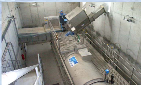
Kompaktna predtretmanska stanica za predtretman otpadne vode (fina rešetka, ventilirani sakupljač pijeska i masti. Za uklanjanje pijeska koristi se patentirani valjčani spremnik.
