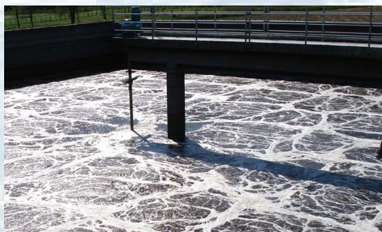
HyperClassic-sustavi za miješanje i aeraciju postižu naknadnu stabilizaciju uskladištenog prekomjernog mulja i istovremeno sprječavaju stvaranje neugodnih mirisa u dijelu sa muljem.
