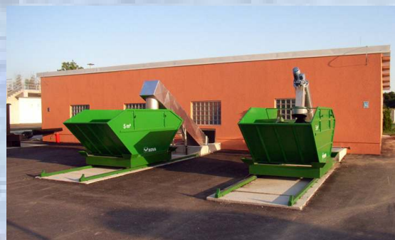
Uklanjanje pijeska i čvrstih tvari iz predtretmanske stanice. Posebnim ispirackim postupkom veliki dio organskih sadržaja vraća se natrag u otpadnu vodu.
