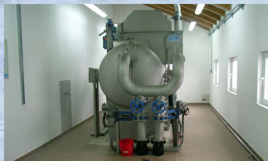
Kompaktna predtretmanska stanica sa finom rešetkom te ventiliranim sakupljačem pijeska i masti.
