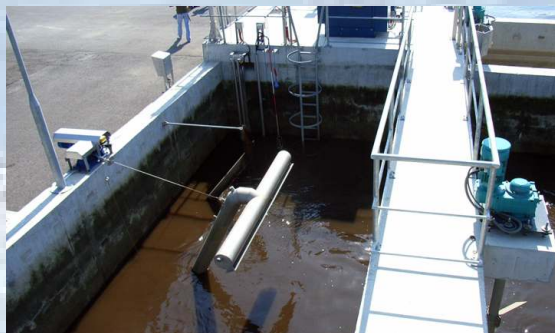
Odvod bistre vode vrši se pomoću posebno u tu svrhu razvijenim BSK®-dekanterom.
