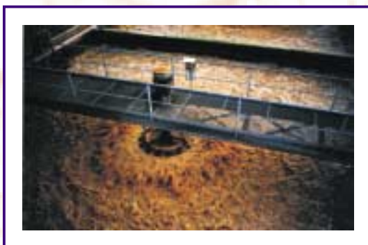
Turbine BSK® installée sur un pont fixe BSK®-Turbine installed at a fixed bridge
