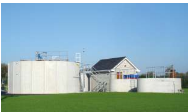
SBR-Kläranlage Gemeinde Carrig, Irland
