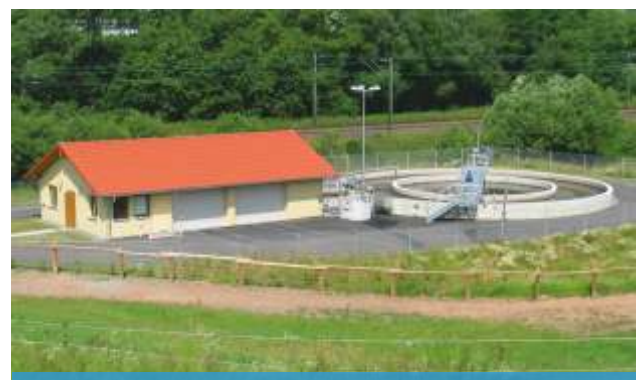
Kläranlage Gemeinde Niederlinxweiler, Deutschland
