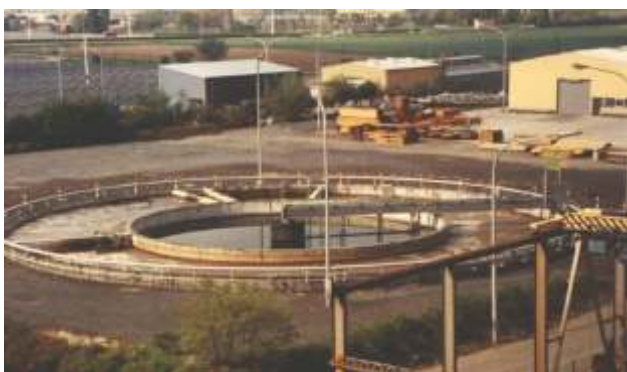
Kläranlage der Adam Opel AG, Deutschland
