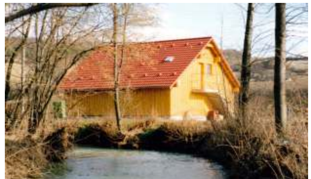
SBR-Anlage Gemeinde Göttern, Deutschland
