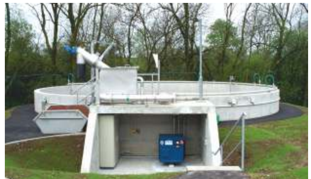
SBR-Anlage Gemeinde Bösleben, Deutschland
