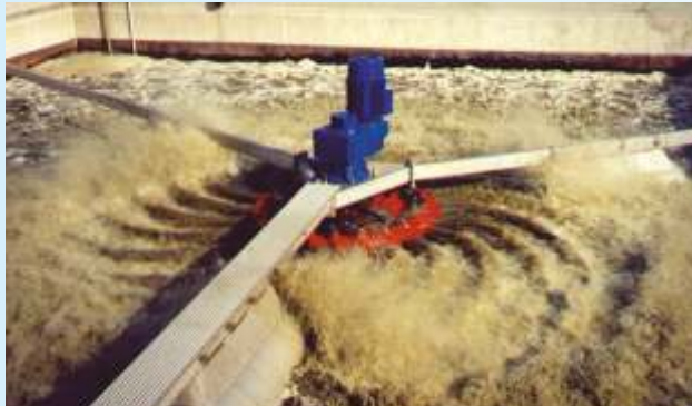
在波兰Krzyz污水处理厂中使用的浮动式BSK®涡轮
