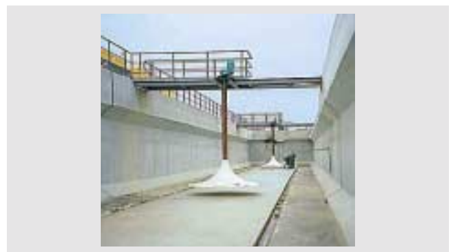
图 3: 在一个脱氮池中的 Hyperboloid 双曲面搅拌器。
