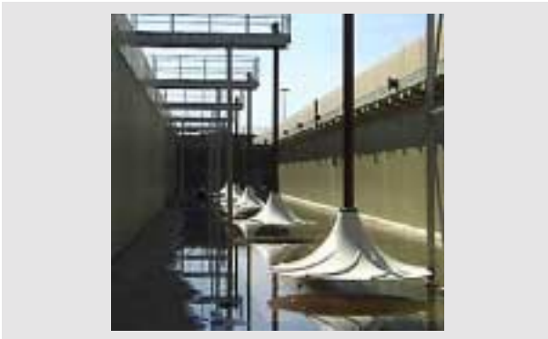
图 4: 某污水厂脱氮池中的 Hyperboloid 双曲面 搅拌器
