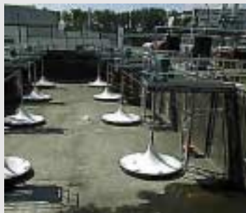
图 7: 某高度输氧需求的工业污水处理厂中安装的 Hyperboloid 双曲面曝气系统。
