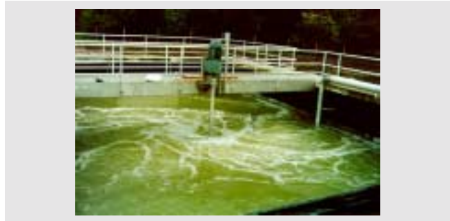
图 5: 由 Hyperboloid 曝气系统进行曝气的某生物池表面
