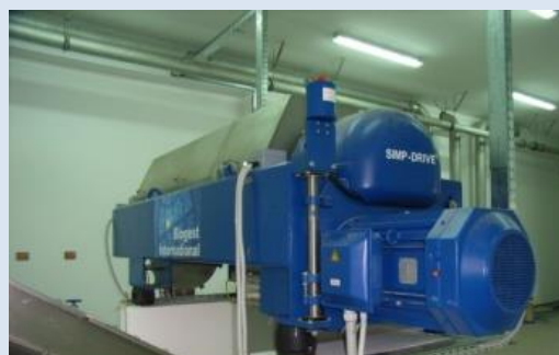
Hochleistungs-Schlamm-trennungszentrifuge mit einer Leistung von 25 m³ Schlamm pro Stunde. Das Entwässerungsergebnis beträgt > 25 % TS.
