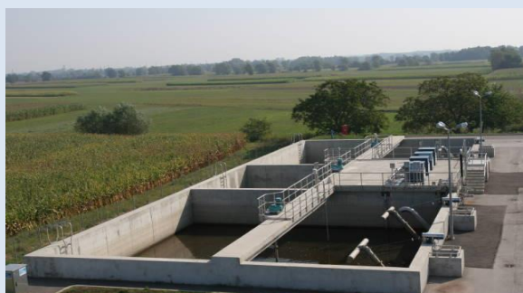
Kläranlage der kroatischen Stadt Virje (5.000 EW) mit zwei SB-Reaktoren, komplett entworfen und ausgestattet von der Biogest International GmbH.
