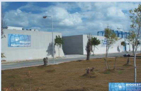
Biogest-Kläranlage der ägyptischen Stadt "Amreya" bei Alexandria. Die hydraulische Leistung liegt zwischen 5.000 – 6.000 m 3 /d, welche mit 3 SB-Reaktoren behandelt wird. Belüften und Rühren erfolgt durch schwimmende BSK ® -Turbinen Ø 2.50 m.
