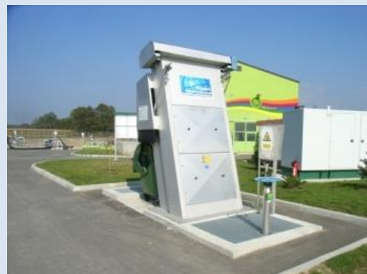
Automatischer Grobrechen für die mechanische Vorreinigung von Abwasser. Vollständig hergestellt aus Edelstahl, um eine lange Lebensdauer, keine Korrosion und einen gewissenhaften Betrieb zu gewährleisten.
