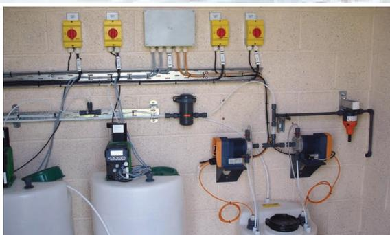
Dosieranlagen für BIOCELL und Chlor im Betriebsgebäude
