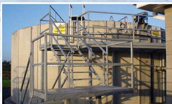
Bedienpodest für die Bedienung und Wartung der Anlage
