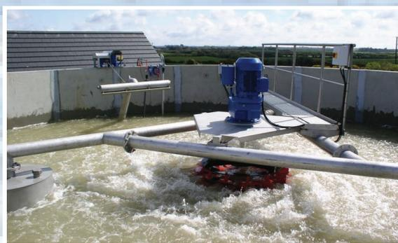
Oberflächenbelüfter (BSK®-Turbine) mit Schwimmsystem
