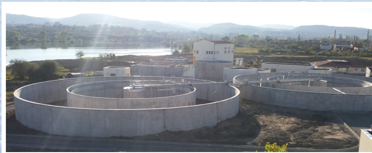
Kläranlage Kardzhali kurz vor der Inbetriebnahme
