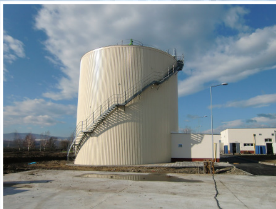
Faulturm zur anaeroben Behandlung des biologischen Überschussschlammes und des Primärschlammes zur Methangasgewinnung
