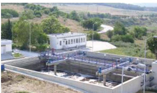
Instalación SBR, Ayuntamiento de Beloslav, Bulgaria
