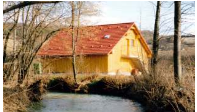
Instalación SBR, Ayuntamiento de Göttern, Alemania
