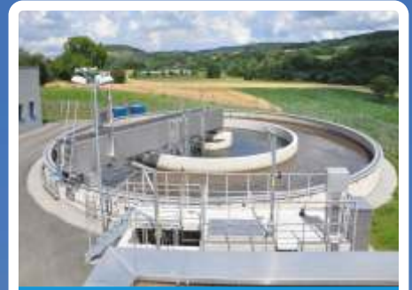
Construcción de instalaciones
