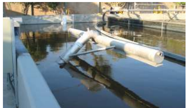
Decantador BSK ® , depuradora Cadbury, México
