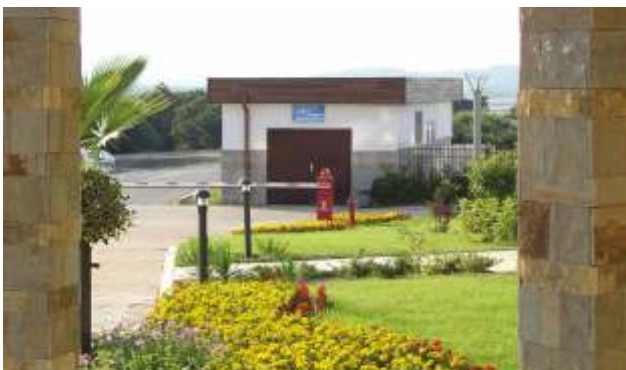
Depuradora SBR del hotel "Humata", Bulgaria
