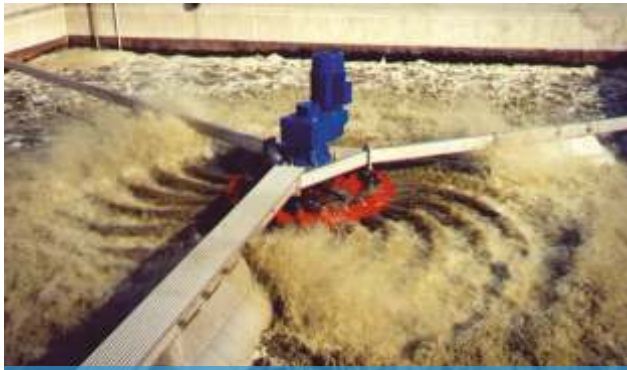
Installation d'assainissement SBR commune Krzyz, Pologne
