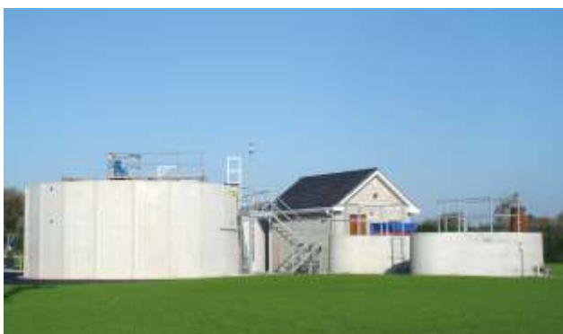
Installation d'assainissement SBR commune Carrig, Irlande
