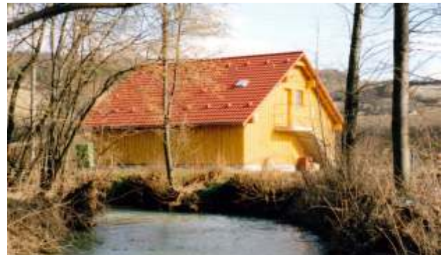
Installation SBR commune Göttern, Allemagne
