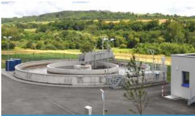
Installation d'assainissement, commune de Gersheim, Allemagne
