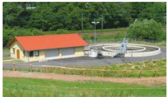
Installation d'assainissement, commune de Niederlinxweiler, Allemagne
