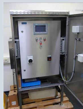
Die Steuerung eines BSK®-Dekanters kann über eine lokale Steuerstelle (links) oder über einen eigenen Schaltschrank mit SPS (Mitte und rechts) erfolgen
